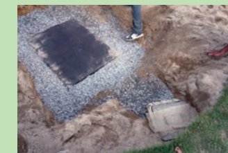
3. 碎石を周囲に入れ込みバンカー砂との境目まで埋戻し
