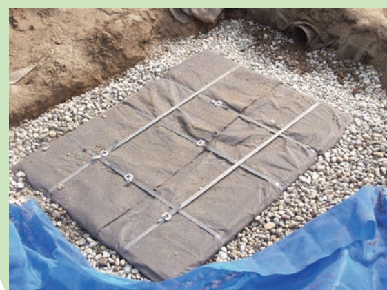
実際の埋設状況
