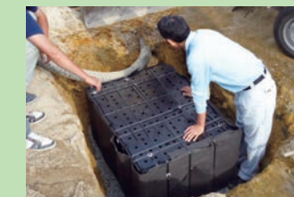
2. 位置決め 上部の透水シートは作業の邪魔なので外しています。
