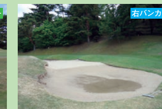
3. 碎石を周囲に入れ込みバンカー砂との境目まで埋戻し
