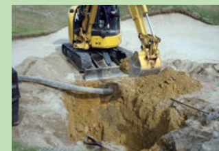
1. バンカー砂を除去し、掘り進める
